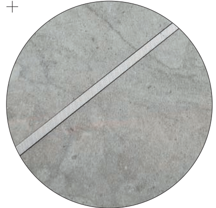
Detalle de inserción metálica
