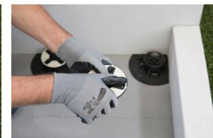
Limpiar la superficie existente y comprobar la planicidad de la solera para elegir el soporte más adecuado que se debe utilizar. La solera debe estar seca y haber completado su fraguado. Preparar los soportes seleccionados, cortando a medida los soportes perimetrales y eliminando las aletas sobrantes.
