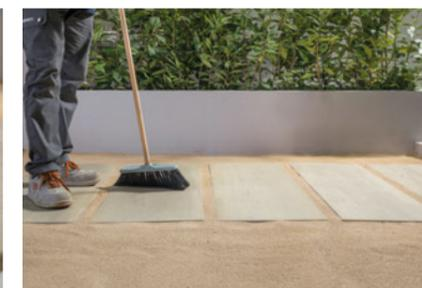
Rellenar con arena las juntas para nivelar el pavimento. Limpiar la superficie de las baldosas.
