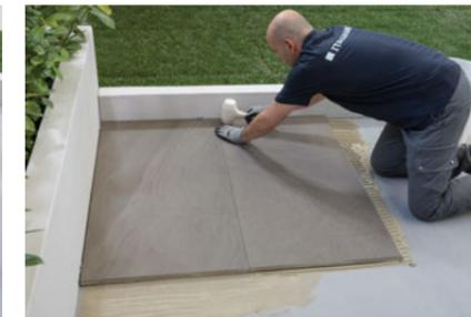
Die Platten aufsetzen und leicht mit einem Gummihammer abklopfen, damit unter den Platten vorhandene Luft austreten kann und ein perfektes Anhaften gewährleistet ist. 4/5 mm breite Abstandhalter in den Fugen einsetzen.
