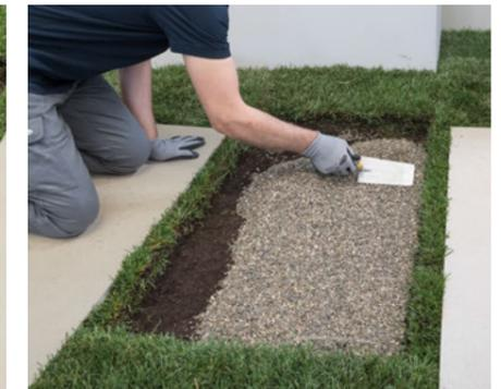
Marcar el área de terreno que se debe retirar y excavar un hueco de una profundidad mínima de 5 cm. Colocar una capa de grava (de 3/6 mm de diámetro) de 3 cm como mínimo.
