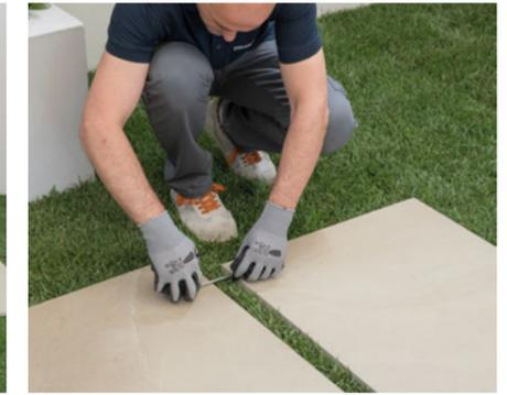
Colocar las baldosas en seco sobre la hierba y comprobar que la distancia entre sí sea regular en toda la superficie colocada.
