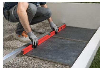
**Verificare la planarità della posa ottenuta. Aggiungere ghiaia tra le fughe per livellare la pavimentazione. E' possibile utilizzare anche ghiaia decorativa di diametro superiore rispetto a quella posata sul il sottofondo.**
