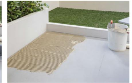
Limpiar la superficie existente y comprobar que la solera esté perfectamente realizada: planicidad, secado y fraguado. Extender el adhesivo de forma homogénea sobre la superficie.
