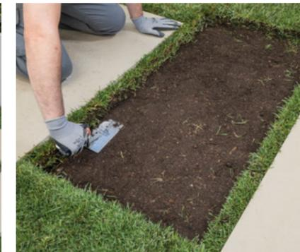
Die zu entfernende Erdbodenportion anreissen und eine mindestens 5 cm tiefe Ausgrabung fertigen. Eine mindestens 3 cm dicke Kiesschicht (Durchm. 3/6 mm) bilden.
