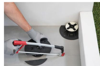
Die vorhandene Oberfläche säubern und den Estrich auf Ebenheit prüfen, um zu bestimmen, welche Stützen verwendet werden müssen. Der Estrich muss trocken und belegreif sein. Die gewählten Stützen vorbereiten, die Randstützen auf das richtige Maß zuschneiden und die überflüssigen Teile entfernen.
