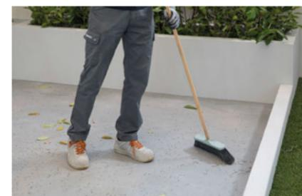
**Pulire la superficie esistente e verificare la planarità del massetto per identificare il giusto supporto da utilizzare. Il massetto deve essere asciutto e stagionato. Preparare i supporti selezionati, tagliando a misura i supporti perimetrali ed eliminando le alette superflue.**
