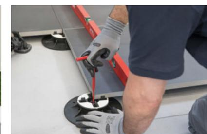
Colocar las baldosas en seco sobre los soportes. Añadir un soporte en el centro de la baldosa eliminando las aletas distanciadoras. Comprobar sistemáticamente la planicidad y regular la altura de cada soporte con la llave especial de regulación para compensar eventuales irregularidades del soporte. Recomendamos verificar y adecuar el nivel de la superficie para evitar el riesgo de estancamiento de agua.
