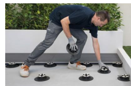
Die Platten trocken auf den Stützen positionieren. Eine Stütze an der Plattenmitte hinzufügen und die Abstandhalterflügel beseitigen. Die Ebenheit systematisch überprüfen und die Höhen der Stützen mit dem entsprechenden Einstellschlüssel regeln, um eventuelle Unregelmäßigkeiten des Untergrundes auszugleichen. Bitte das entsprechende Gefälle berücksichtigen um Staunässe zu vermeiden.
