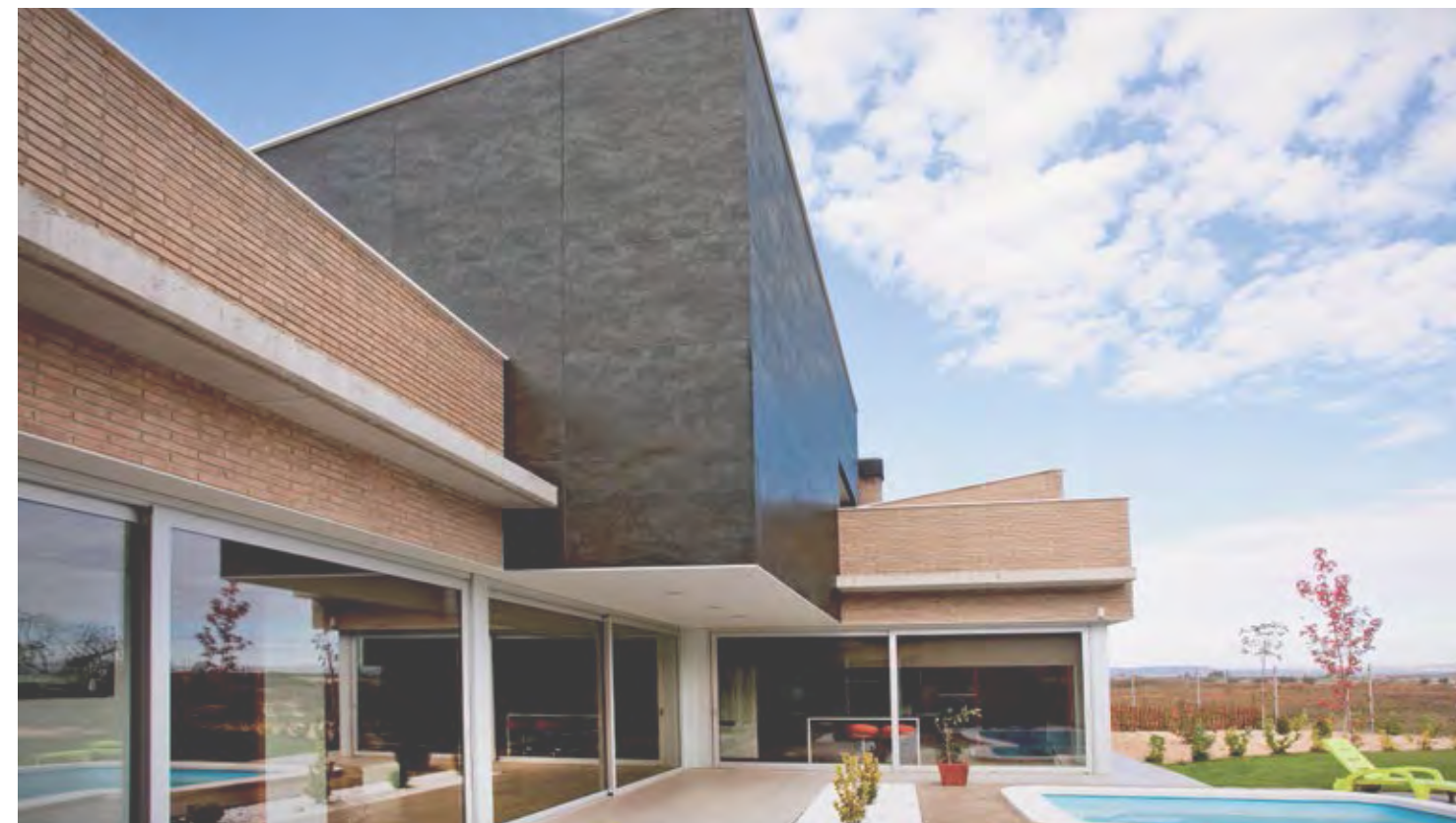
III Revestimiento: Coverlam Oxido Negro 100 x 300 (piezas cortadas a 150 x 100 / rectified pieces to 150 x 100).
