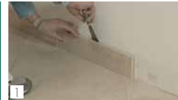
1 Eliminare il battiscopa Remove skirting
