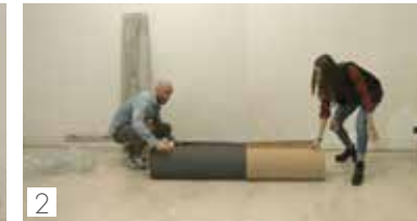
2 Stendere il tappetino Lay the underlayer
