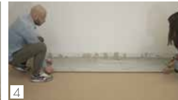
4 Posare il pavimento senza fuga Lay the floor tiles with close joints
