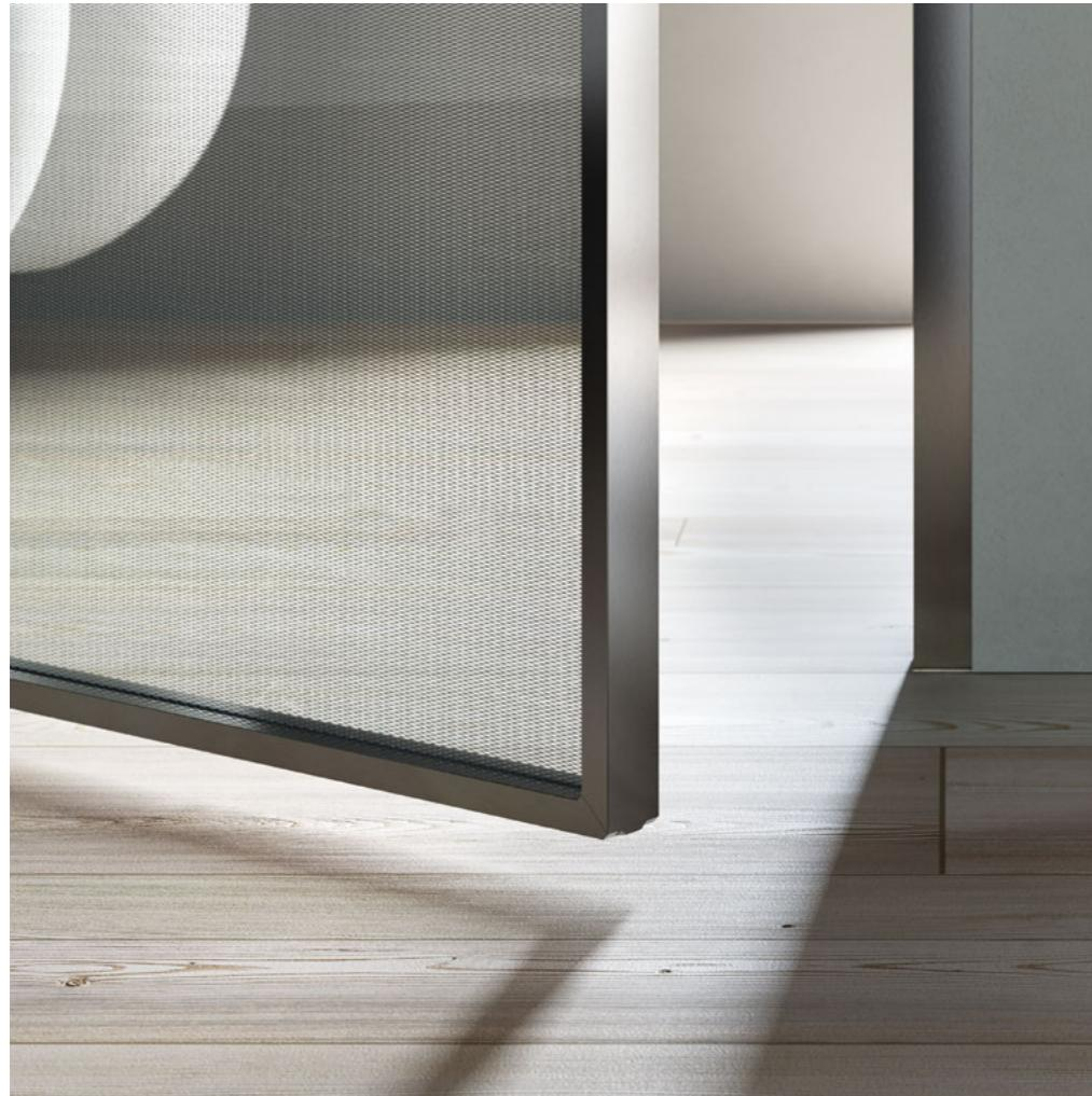
I sottili ed essenziali profili estrusi in alluminio lega primaria di Suite – qui con finitura acciaio spazzolato – garantiscono elevata resistenza strutturale e livelli di portanza delle grandi lastre di cristallo, pur con spessori relativamente contenuti. Una caratteristica che amplifica la versatilità del sistema sia dal punto di vista del disegno, sia in termini di personalizzazione dei materiali e delle soluzioni costruttive.
